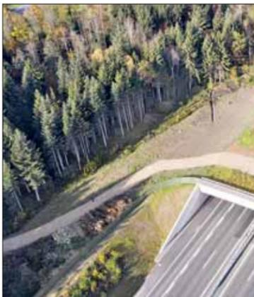
In Neuenkirch hat man für die rund 36 m breite und 50 m lange Wildtierbrücke aneinandergereihte, gerade BSH-Träger gewählt. Als Auflager dienen die Außenwände und die Mittelwand aus Stahlbeton.
