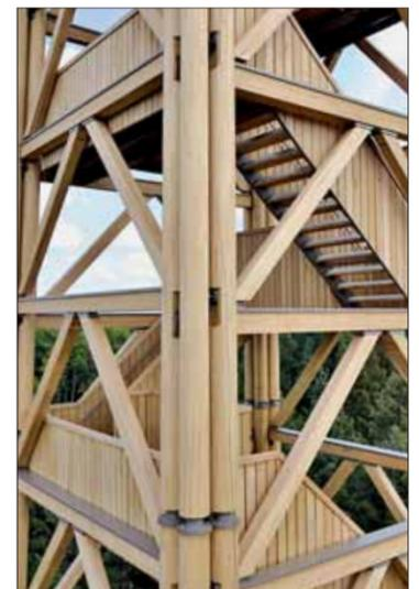
Der 2020 wiederaufgebaute Goetheturm aus Edelkastanien-BSH mit neu entwickelten Anschlussdetails soll langfristig der Witterung trotzen.
