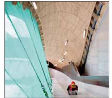
Die Überdachung der Rennschlittenbahn ist weitestgehend stützenfrei ausgeführt. Auf der Innenseite erhält die neue Dachschale eine Holzleistenschalung.
