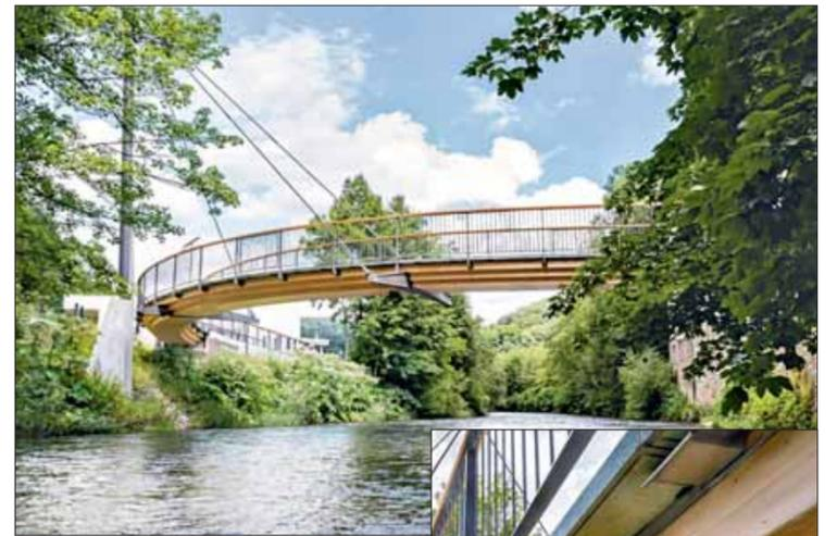
Viertelkreisförmig geschwungene Schrägseilbrücke aus Holz: Der 36 m lange, blockverklebte BSH-Träger kam wegen der zwei Abspannungen mit einer Höhe von nur 60 cm aus. Seitlich abgestuft und mit überstehendem Fahrbahnbelag gehört sie zum Typus der „geschützten Brücke“.
